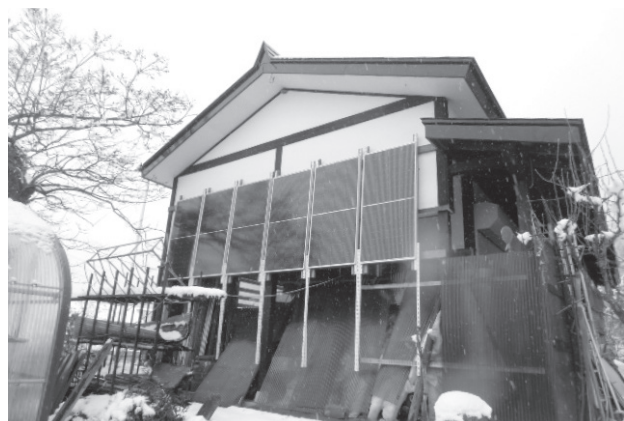
側面に太陽光発電パネルを設置した家屋
